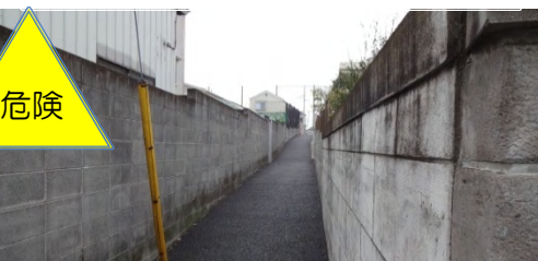
周囲からの視線がない トンネル構造の場所
