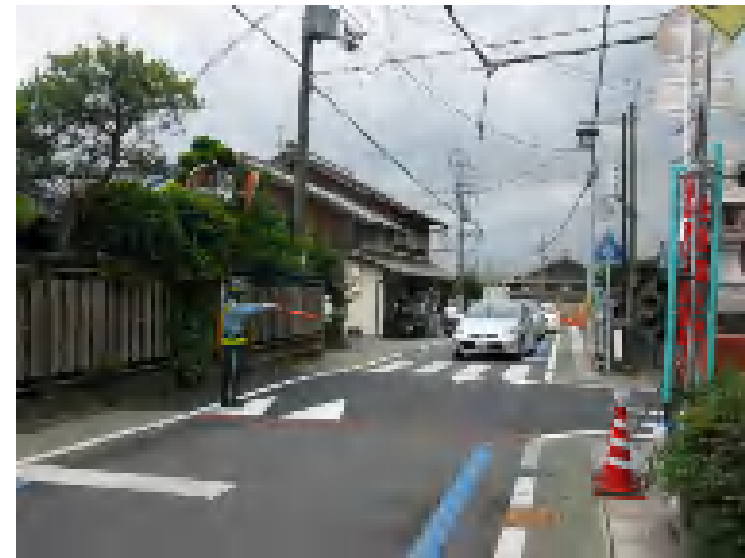
ハンプ(路面の凹凸)設置箇所
